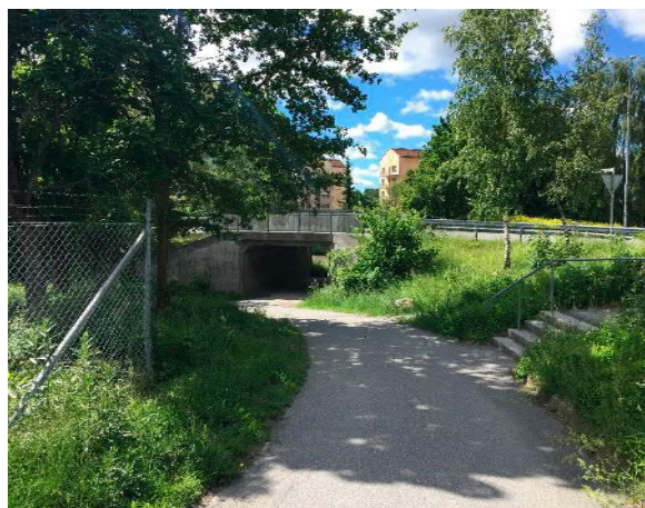
Gång- och cykeltunnel under Ulvsättravägen
