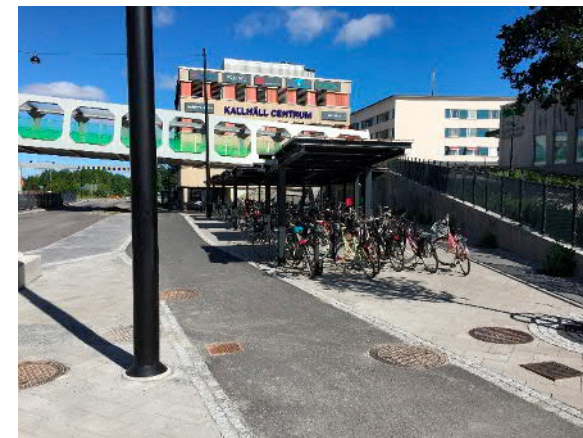
Figur 3.4 Väderskyddad cykelparkering vid Kallhälls station. Avstånd mellan fasta hinder och cykelbana är för litet vilket leder till större olycksrisk och sämre framkomlighet.
