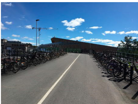
Figur 3.5 Gång- och cykelbro i Kallhäll med tillräcklig bredd för skiljelinje mellan gående och cyklister. Cykel- och gångsymboler saknas.
