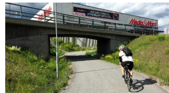
Gång- och cykeltunnel vid Barkarby trafikplats.
