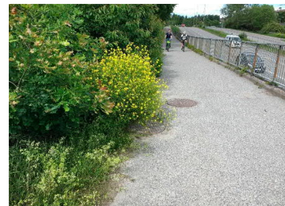
Figur 6.2 Växtlighet tränger in på gång- och cykelbana och begränsar framkomligheten för gående och cyklisterna
