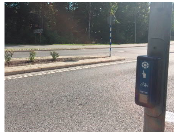
Figur 5.12 Tryckknappslådan bekräftar detektering genom att lysa upp.
