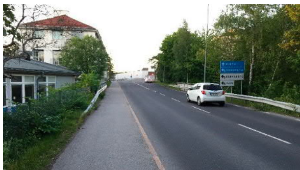
Skälbyvägen med vy mot Barkarbybron. Närmast i bild passerar gång- och cykeltunneln till Barkarby skolan under vägen.
